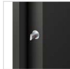
4 ZAJIŠŤOVACÍ ČEPY PROTI VYSAZENÍ DVEŘÍ
